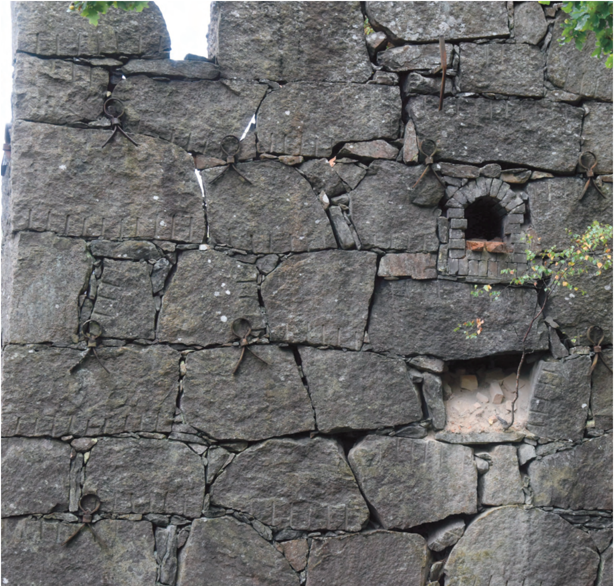
Stenmaterialet i den nordöstra muren. Borrsömmarna framträder tydligt i många stenar. De flesta borrsömmar har placerats nedåt, medan andra är placerade åt sidan, sådana som placerats uppåt förekommer dock.
