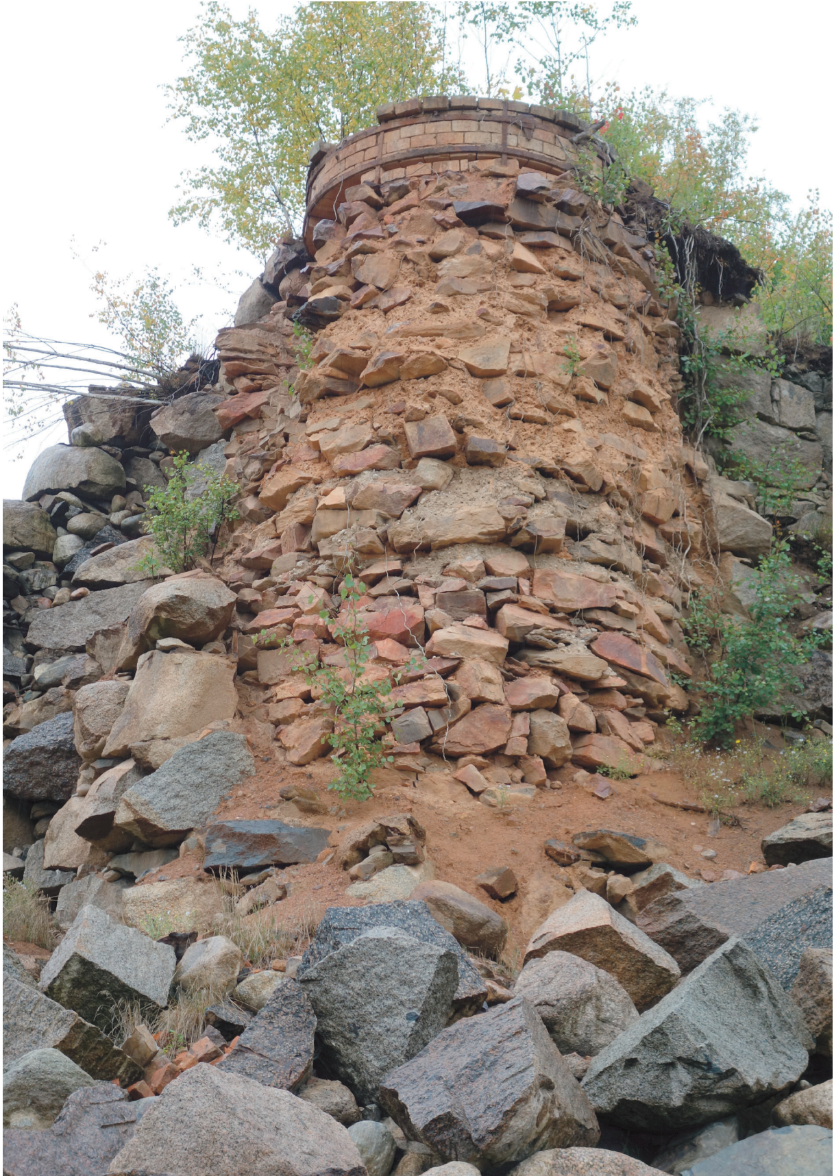
Mur av mindre stenmaterial med en mer gul-röd kulör och jämnare kloytor. Detta murverk ligger närmast pipan och är murat med lerbruk till skillnad från en i övrigt kallmurad konstruktion.
