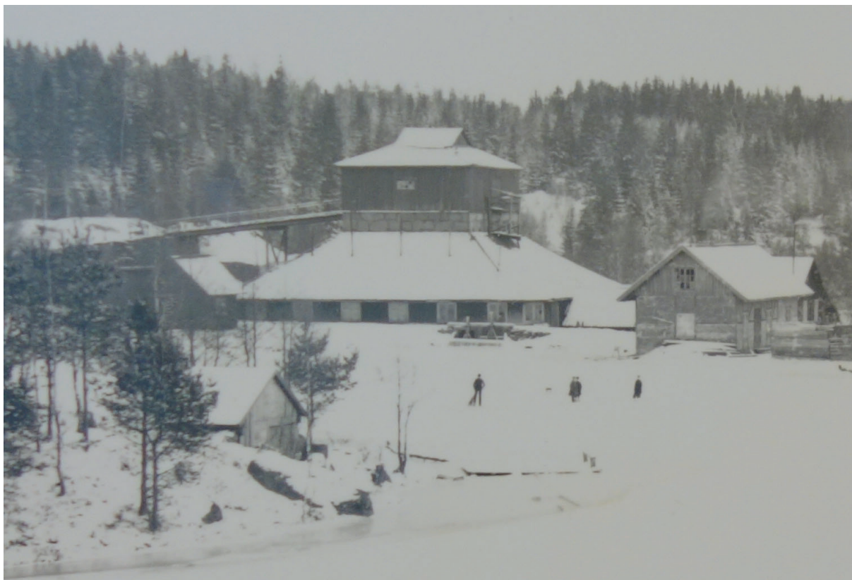
Utdrag ur fotografiet ovan, här syns masugnens utformning med överbyggnad, tak och kringliggande träbyggnad. Här syns även körbron upp till masugnens krön. Framför masugnshygggnaden syns dammluckor till rännan för blåsmaskinens drift (Kronobergsarkivet).
