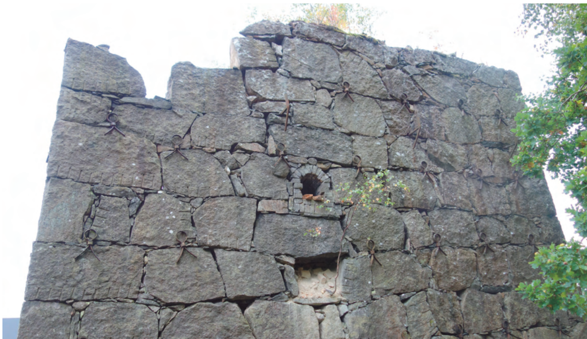
Högt upp på den nordöstra fasaden finns en tegelfodrad, välvd öppning.
