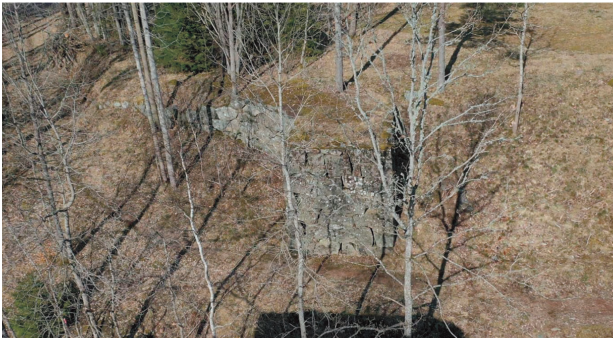
Drönarfoto av körbron sedd från masugnens krön. Fundamentet svänger mot nordväst.
