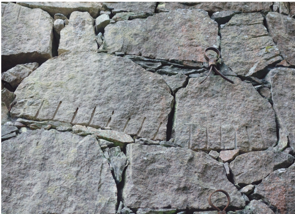
Stenar i fasaden. De större blocken snittar ca 600 mm i höjd, många är nästan kvadratiska, andra är närmre en meter breda. Här syns borrhömmar tydligt, dessa har placerats nedåt.
