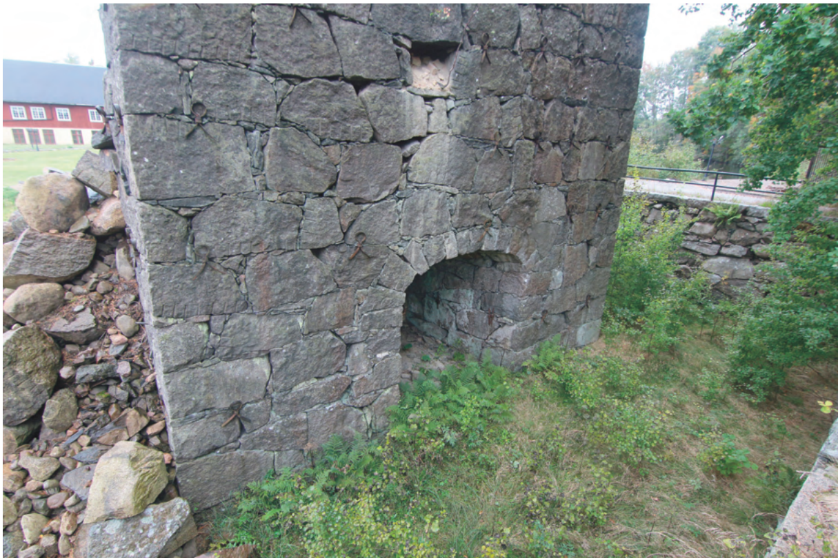
Masugnens nordöstra fasad med kallmurad mantelmur, välvd öppning i marknivå samt en mängd ankarslut i murverket.
