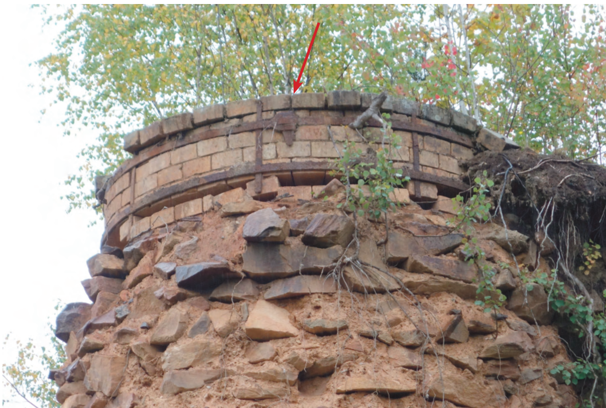
Järnbandets sammanfogning med käl (pil) syns här. Även de vertikala järnbanden som binder samman de två omslutande banden syns.
