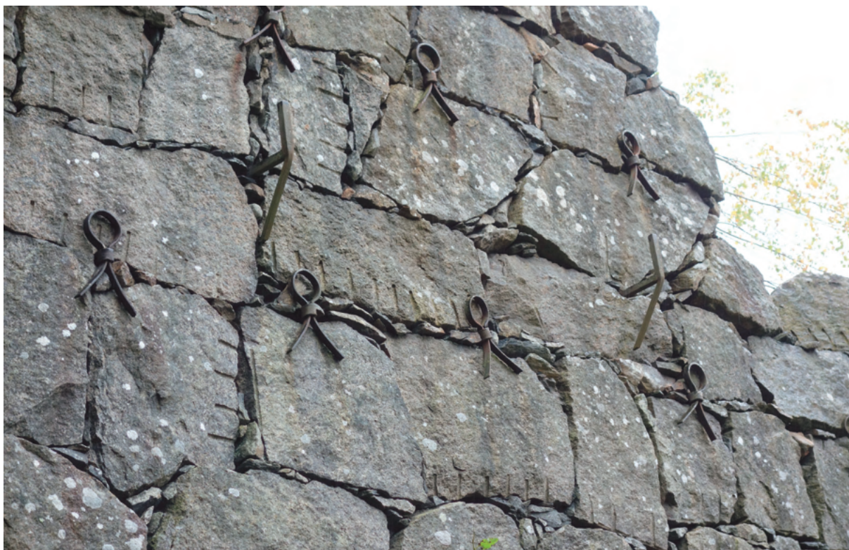
Ankarlut med ögleform spridda över den nordvästra fasaden. Här syns även de smidda konsolerna.
